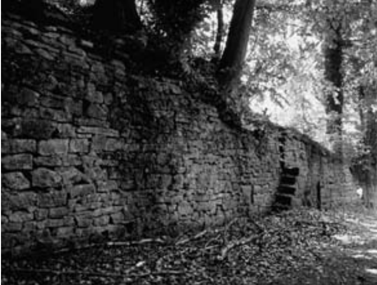
Eine 40 Meter lange und bis 2.5 Meter hohe Trockenmauer mit einer integrierten Seitentreppe stützt den Hang bergseits der Zufahrt zum ehemaligen Steinbruch von Eckwil bei Mägenwil ab (AG 680.3).
