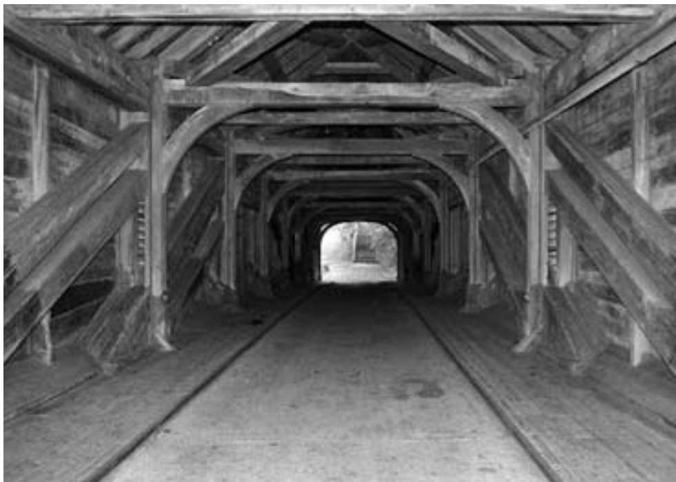
Das 1227 gegründete Zisterzienserkloster Wettingen erkannte schon früh die Einkunfts-möglichkeiten aus dem Verkehr von Zürich nach Baden und richtete eine Limmatfähre ein, die erst 1764–66 durch eine Brücke ersetzt wurde. Die heute noch erhaltene gedeckte Holzbrücke datiert von 1819 (AG 2.2.1).
