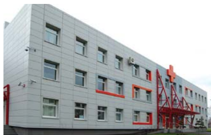
Подстанция «Скорой помощи» на ул. Александровка
