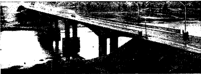
Рис. 1. Общий вид моста
