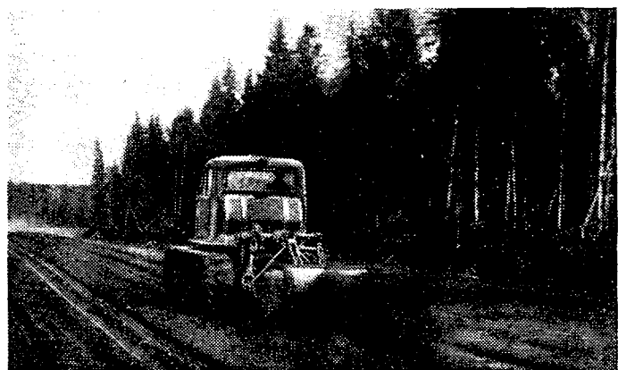
Рис. 5. Перемешивание увлажненной смеси болотной фрезой ФБН-0,9 с трактором ДТ-75.
