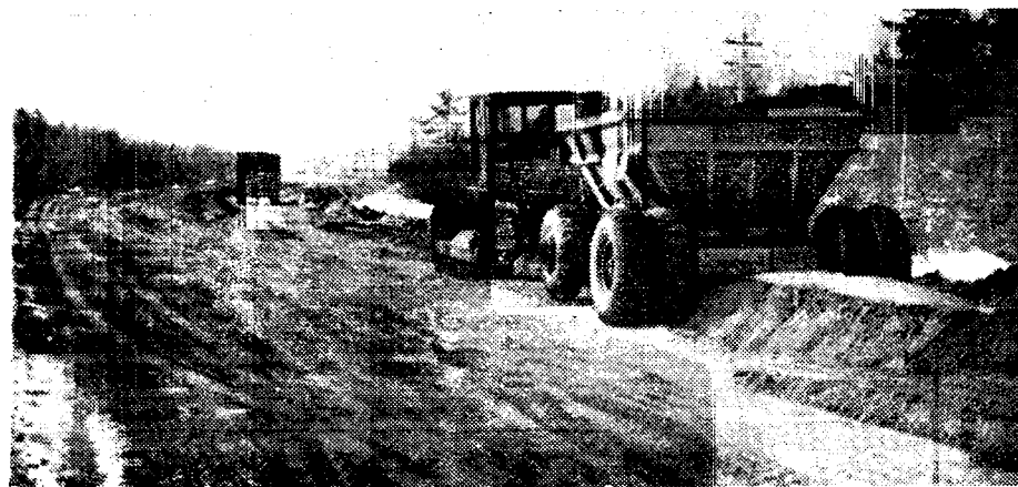
Земляные работы в ДУ-356
