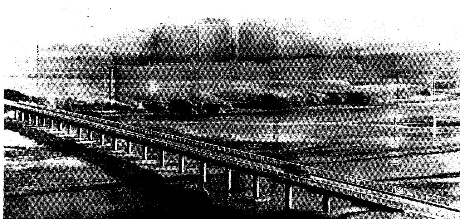
Мост на одностолбчатых опорах через р. Феррахруд Вологодская областная универсальная научная библиотека www.booksite.ru
