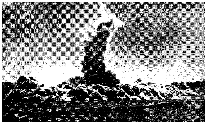
Взрыв в районе скальных работ при устройстве земляного полотна дороги
