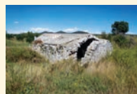
STARE MLINICE NA PUTU ZA VRANU
