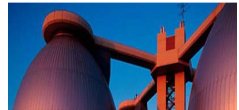
Emschermündung Sewage Plant, Germany Sewage Gas / 5.0 MW / 4 units
