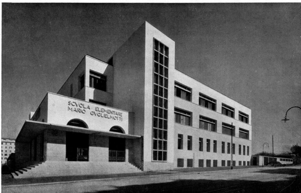
LA SCUOLA ELEMENTARE «MARIO GUGLIELMOTTI» IN ROMA. - VISTA LUNGO LA VIA VETULONIA. - La colorazione delle facciate è azzurra, a zone digradanti dal basso verso l'alto.
