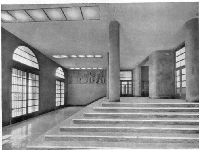
VISTA DELL'ATRIO. - Pavimentazione in marmo verde oliva, gradini in marmo di Carrara e sottogradi verde oliva. - Bassorilievo in cemento dello scultore Francesco Coccia. - Il modellato sintetizza la vita del fanciullo dalla scuola, allo sport, al servizio della Patria. La porta vicino al bassorilievo è l'ingresso dei fanciulli.
