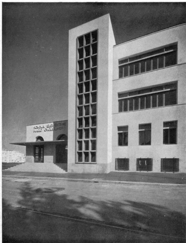
PARTICOLARE DELLA SCUOLA CON VISTA DELL'INGRESSO PRINCIPALE E TORRE DELLA SCALA. - Il finestrone è a struttura di cemento armato. - L'architrave in cemento armato dei grandi finestroni delle aule a causa delle sue dimensioni è disposto nel parapetto del piano superiore.
