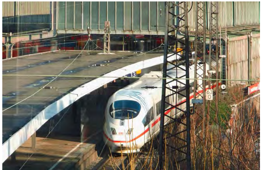
Der Umbau erfolgt „unter rollendem Rad“.
