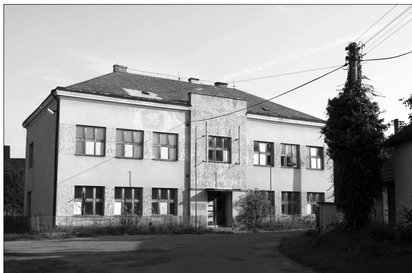
Bývalá školní budova (zmodernizovaná), která dnes už výchově místního dorostu neslouží...
