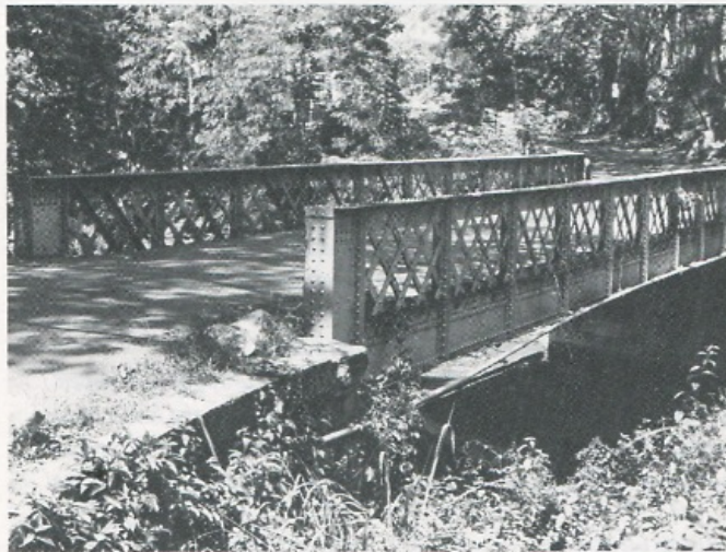
Foto No. 3. Lugar (Site) No. 72. Puente Obispo Zengotita. Obispo Zengotita Bridge. 1878
