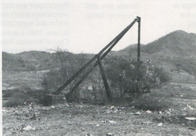
Foto No. 22. Lugar (Site) No. 75. Grúa de caña. Sugar cane hoist. ca. 1930.
