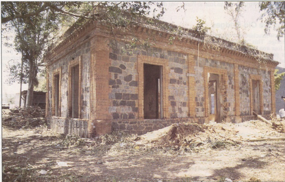
Foto No. 15. Lugar (Site) No. 55. Casilla de caminero. Roadman's house. 1886.
