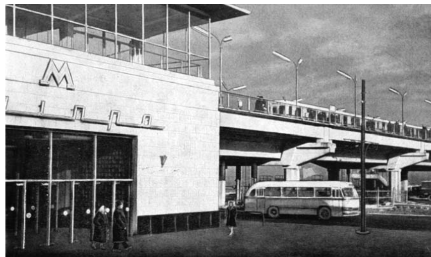
Станция «Днепр», общий вид. Архитекторы С. С. Павловский, Г. И. Гранаткин, П. Ю. Красицкий, А. Ф. Игнащенко, С. О. Крушинский
