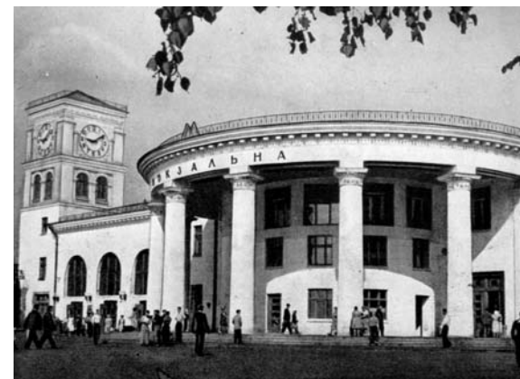
Наземный вестибюль станции «Вокзальная». Вид с привокзальной площади. Архитекторы А. В. Добровольский и И. А. Масленков
