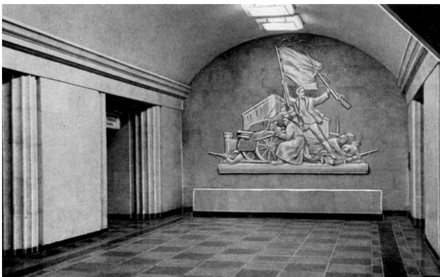
Центральный зал (панно ликвидировано в середине 1990-х) и наземный вестибюль станции «Арсенальная». Архитекторы Г. И. Гранаткин, С. О. Крушинский при участии Н. М. Шукиной
