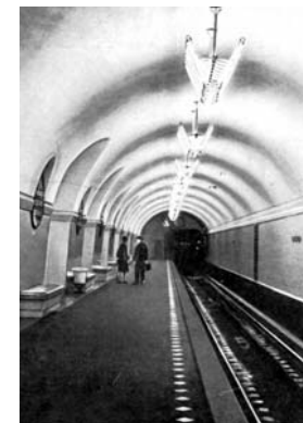
Перронный зал станции «Вокзальная». Архитекторы Е. И. Катонин, В. И. Ежов, В. К. Скугарев, И. Г. Шемсединов, художник А. В. Мызин
