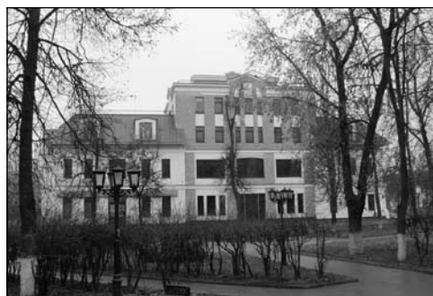
Гостиничный комплекс, построенный на месте торговых рядов начала XXв.
