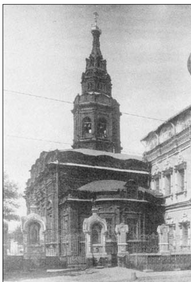
Трапезная, колокольня и придел после перестройки 1904-1905 гг.
