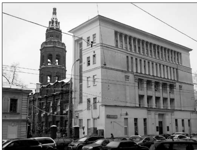
Здание Союзмультифильма и церкви св. Николая Чудотворца Современной состоянии
