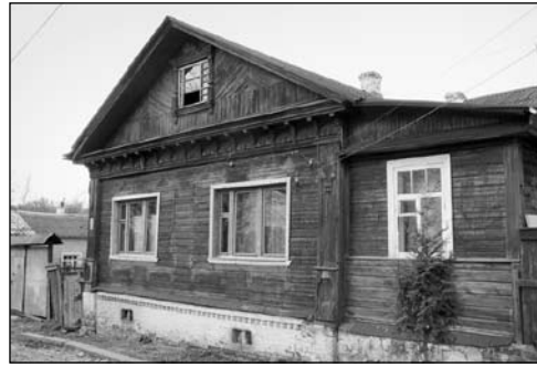
Этот же дом после ремонта
