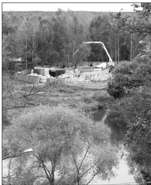
Строительство частного коттеджа на месте древнего храма Трех святителей
