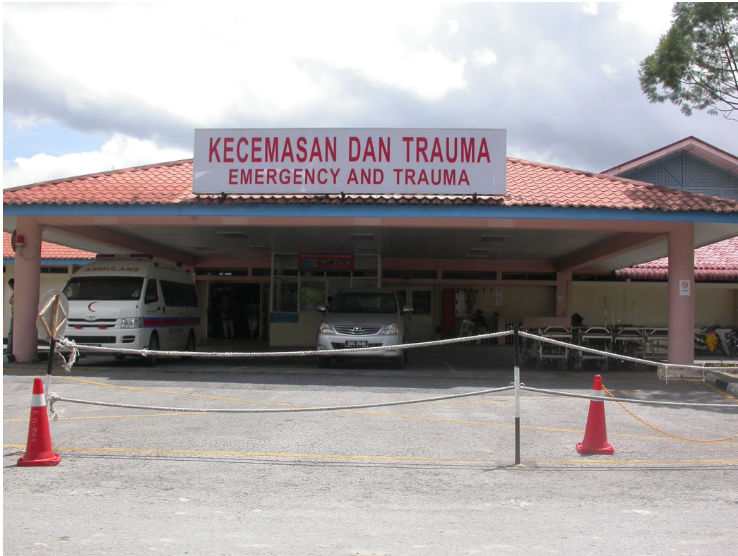
PINTU UTAMA JABATAN KECEMASAN DAN TRAUMA
