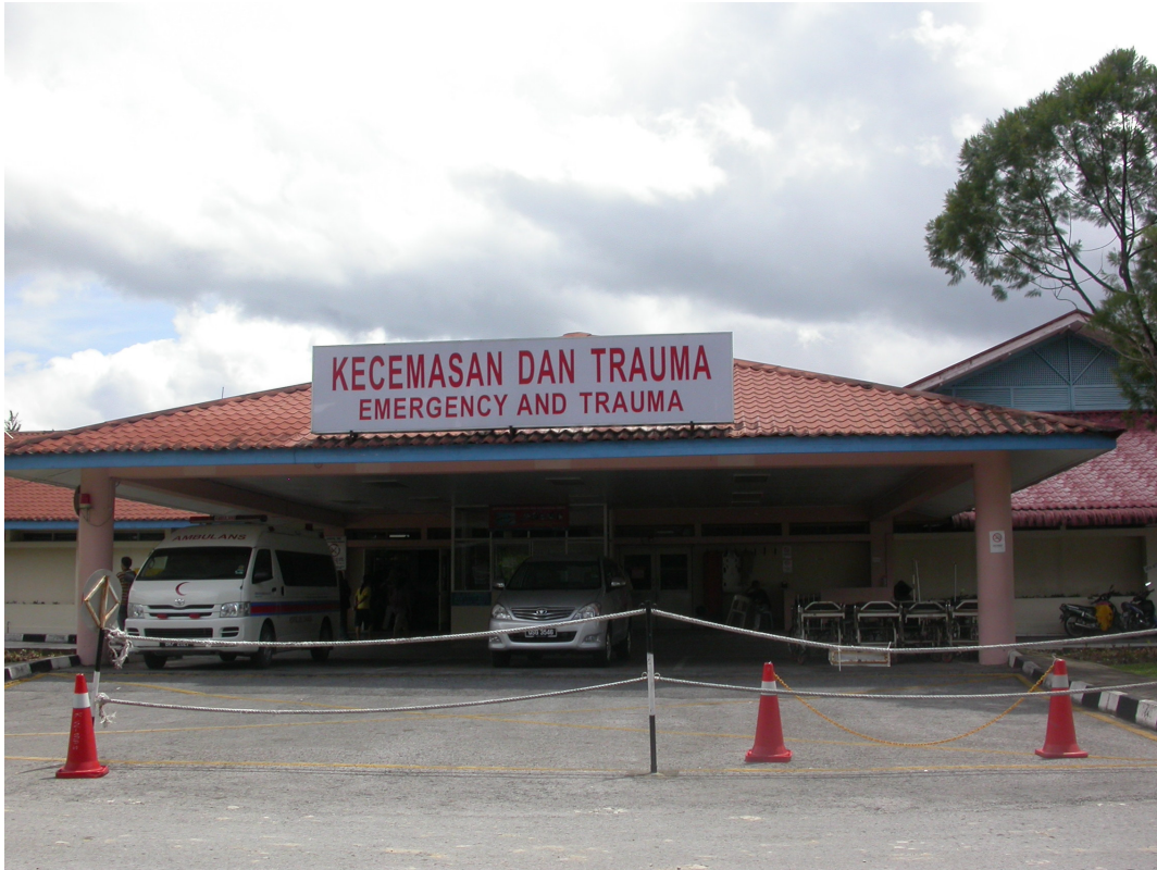
PINTU UTAMA JABATAN KECEMASAN DAN TRAUMA
