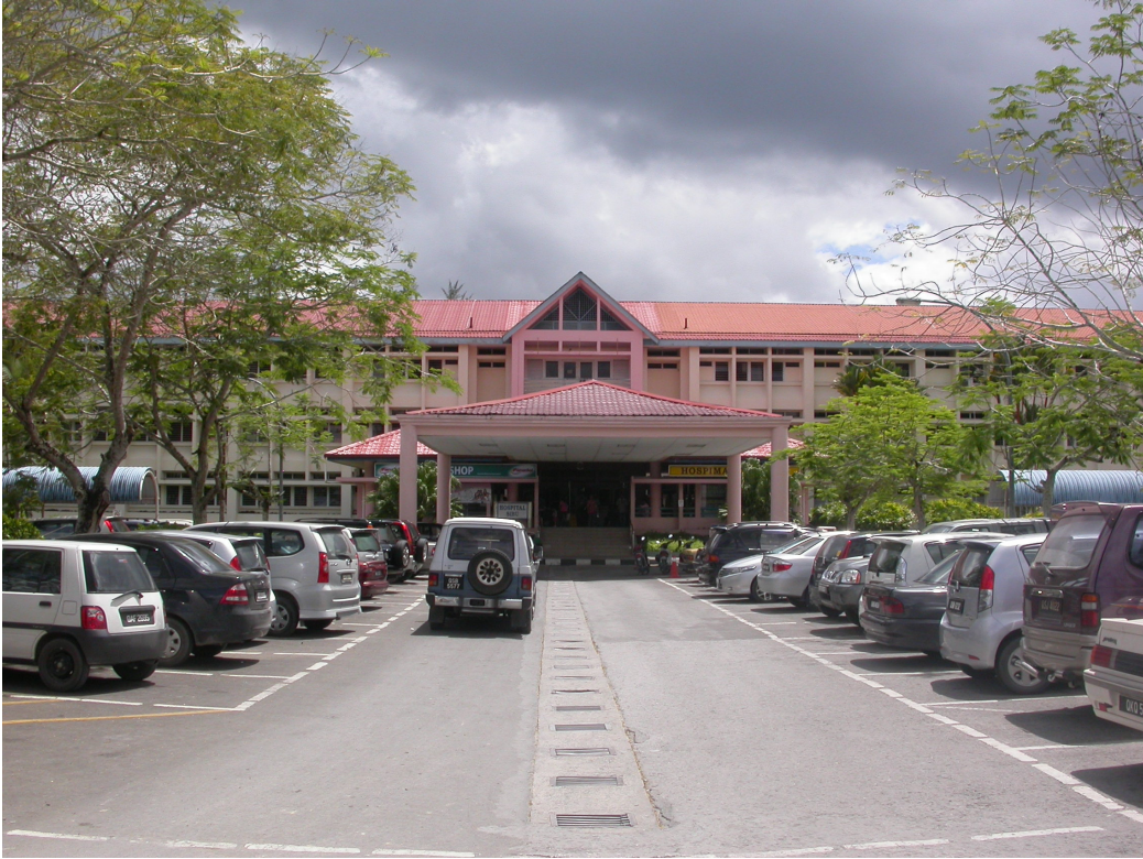
PINTU MASUK UTAMA
