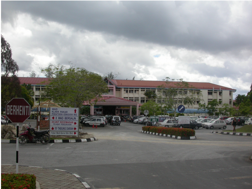
PINTU MASUK UTAMA
