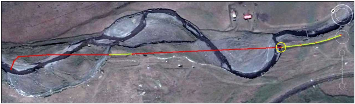
Figura 83. Traza original del terraplén marginal al río Turbio de 620 m de longitud. La imagen satelital fue obtenida el 17 de diciembre de 2007. En trazo rojo se indican los tramos erosionados y en verde los que todavía persistían a la fecha de la imagen. Con el círculo amarillo se indica la localización de la Figura 45.
