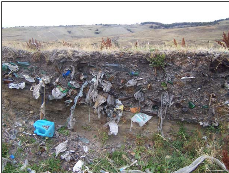
Figura 109. Borde del predio de la Alternativa 1 erosionado por el río. Presencia de desechos de origen desconocido enterrados.
