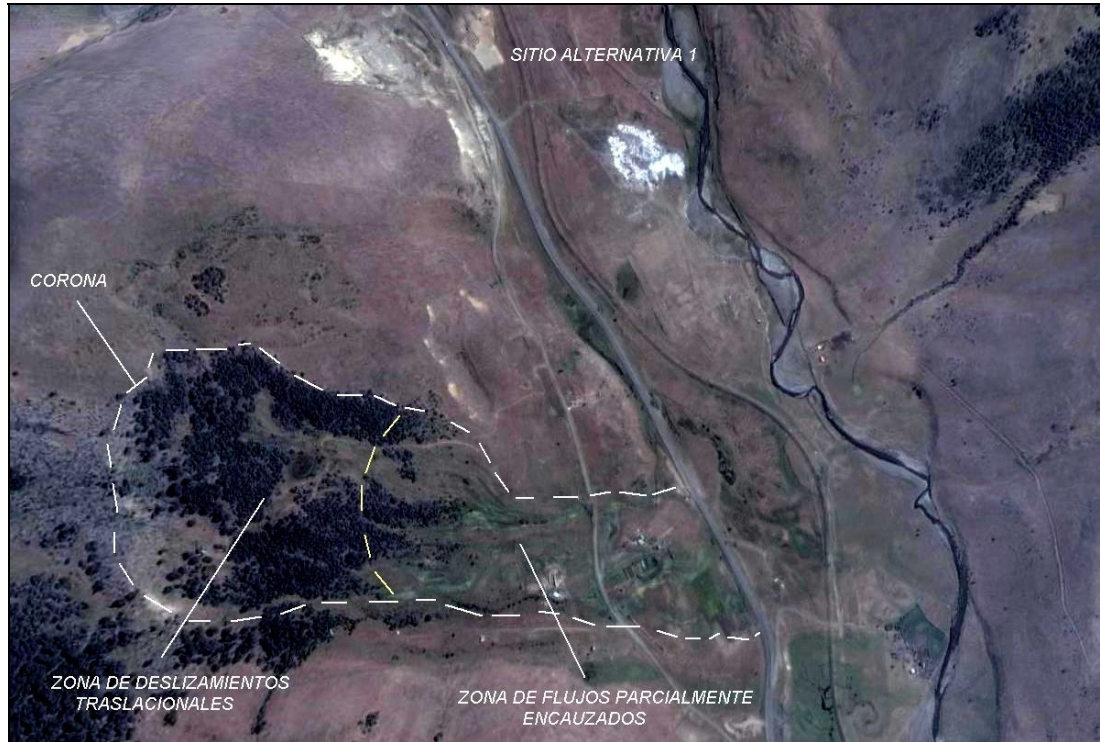
Figura 69. Deslizamiento traslacional que culmina en flujo
