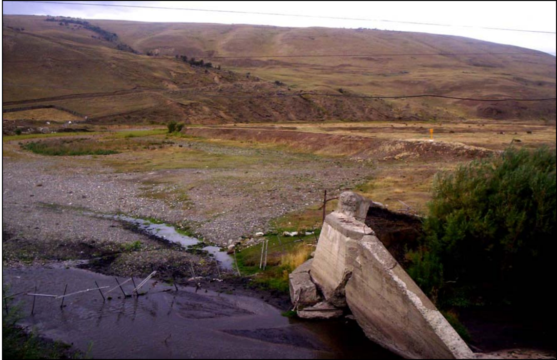
Figura 56. Depósitos de planicie de inundación del río Turbio en el cruce con la ruta 293, cercanías de Julia Dufour. En el primer plano, en zonas aledañas al cauce activo se observan acumulaciones de carbón de granulometrías finas, aportadas por el arroyo San José y provenientes del yacimiento minero. En el segundo plano se observan las gravas gruesas trasladadas por el río Turbio durante los periodos de creciente.
