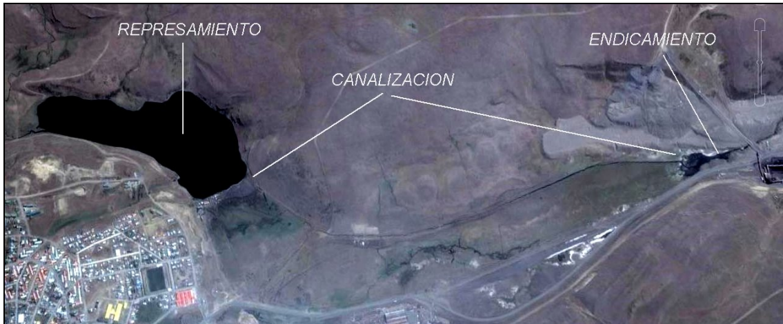
Figura 75. Arroyo San José en la sección severamente modificada por el represamiento, la canalización y el endicamiento, este ultimo generado por el deslizamiento de pilas de estéril sobre su planicie aluvial.
