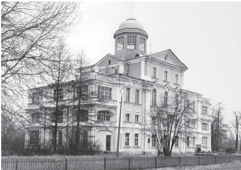
Господский дом М. И. Воронцова с юго-запада. Фото Т. Н. Ладыгиной. 1999 г.
