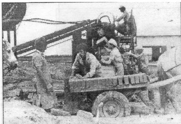
76. Идут работы по формовке и отвозке кирпича-сыр-
