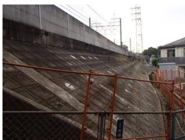
△法面の補強前と補強後（成増～和光市間）
