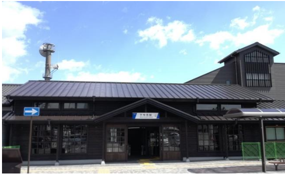
△下今市駅リニューアル（工事中）
