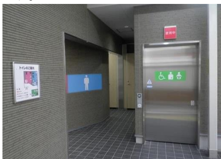
△リニューアル後のトイレ（鐘ヶ淵駅）
