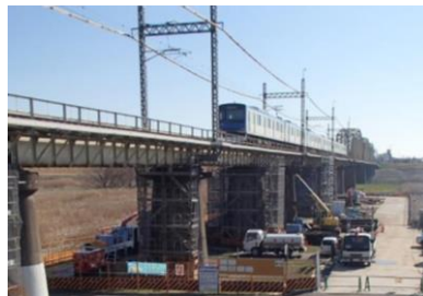
△江戸川橋梁の耐震補強（南桜井～川間間）（工事中）
