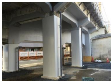
△高架橋耐震補強後（浅草～とうきょうスカイツリー間）
