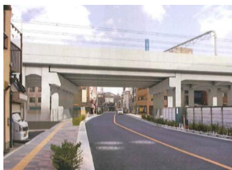
△とうきょうスカイツリー駅付近の高架橋（イメージ）
