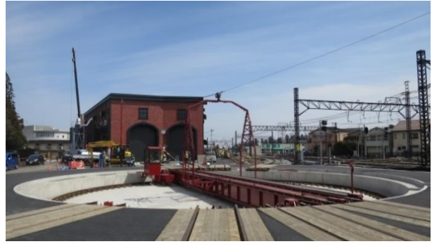
△下今市駅機関庫および転車台（工事中）
