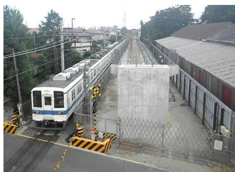
△清水公園～梅郷間の高架橋（工事中）
