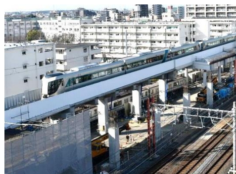
△竹ノ塚駅付近の高架橋（工事中）
