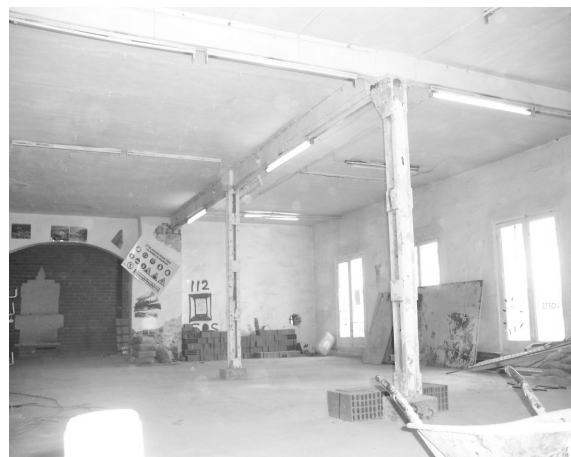
Edificio de 1924 de la calle Quintiliano n.º 6, esquina a Luis Cabrera. Detalle de las vigas.
