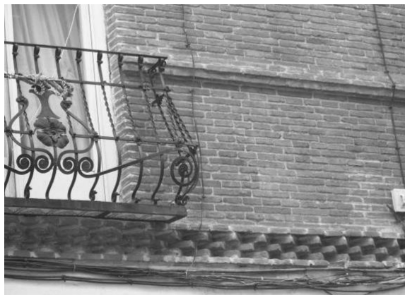
Edificio en calle Juan Bautista de Toledo, 2, donde se aprecian resaltes y rombos en la fachada.
