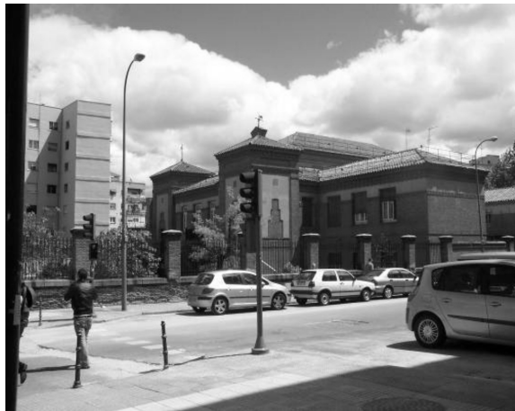
Iglesia de Santa Matilde, en la calle López de Hoyos n.º 166.
