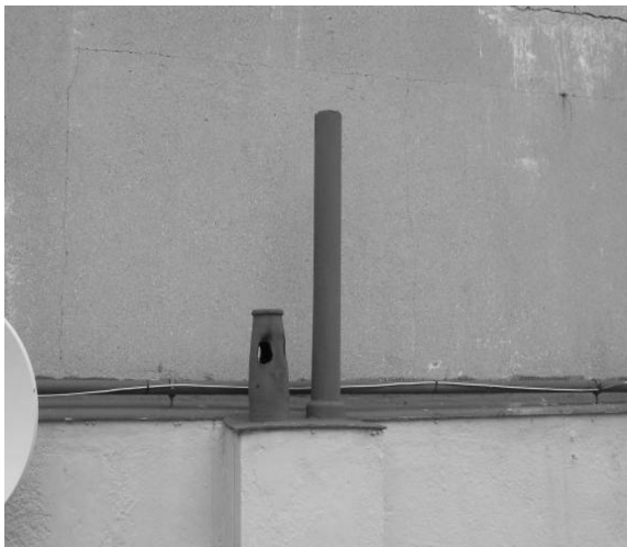
Detalle de la cocina económica y la chimenea del exterior.
