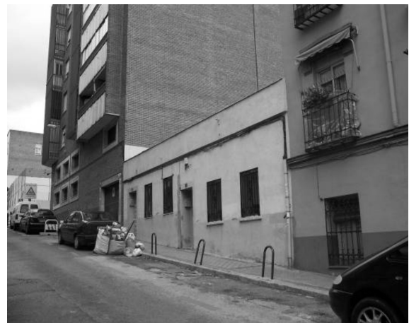
Línea de distribución aérea grapeada sobre fachada en la calle Zabaleta.
