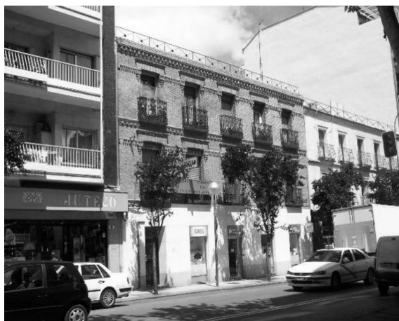
Edificio de la calle López de Hoyos n.º 113.
