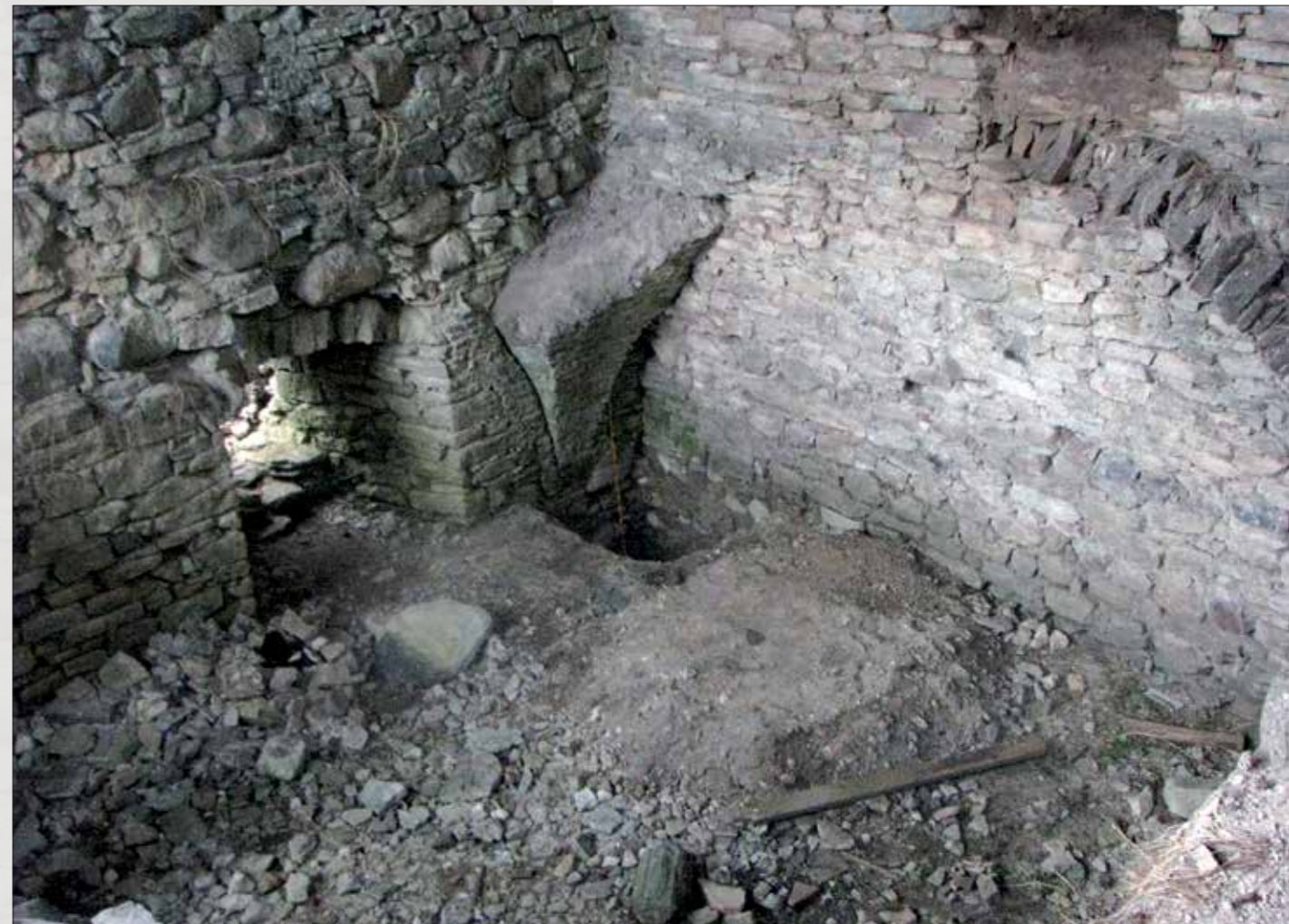
Joonis 14. Lõunatiiva keldrisaali (008) kirdenurk. Sajandeid tagasi purunenud võlve toestab kahe võlviku vahele laotud vahesein (paremal) (foto: Villu Kadakas).
