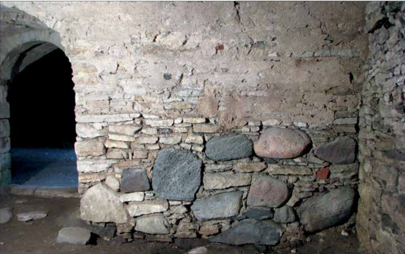
Kuva 5. Püstysauma (oikealla) läntisen ja keskimmäisen kirkonalaisen kellarin (001 ja 002) myöhemmän väliseinän ja pihaseinän välillä (kuva: Villu Kadakas).
