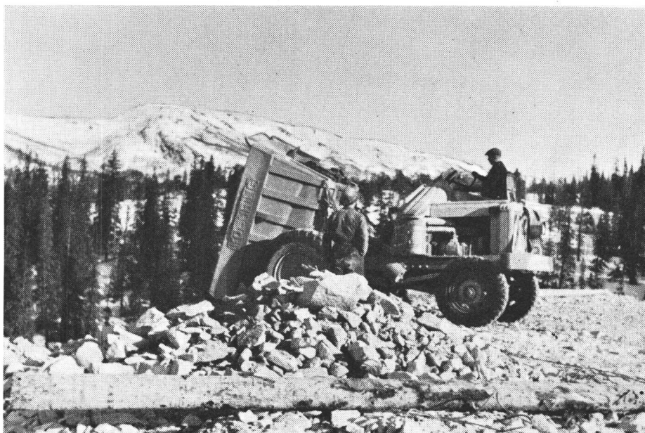
Fig. 32. Koehring Dumptor på tipp ved tverrslag I (mars 1952.).
