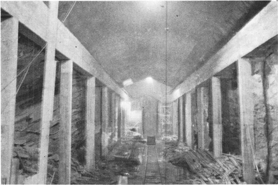
Fig. 22. Aura Kraftanlegg. Nordre rørfordelingskammer våren 1952.
