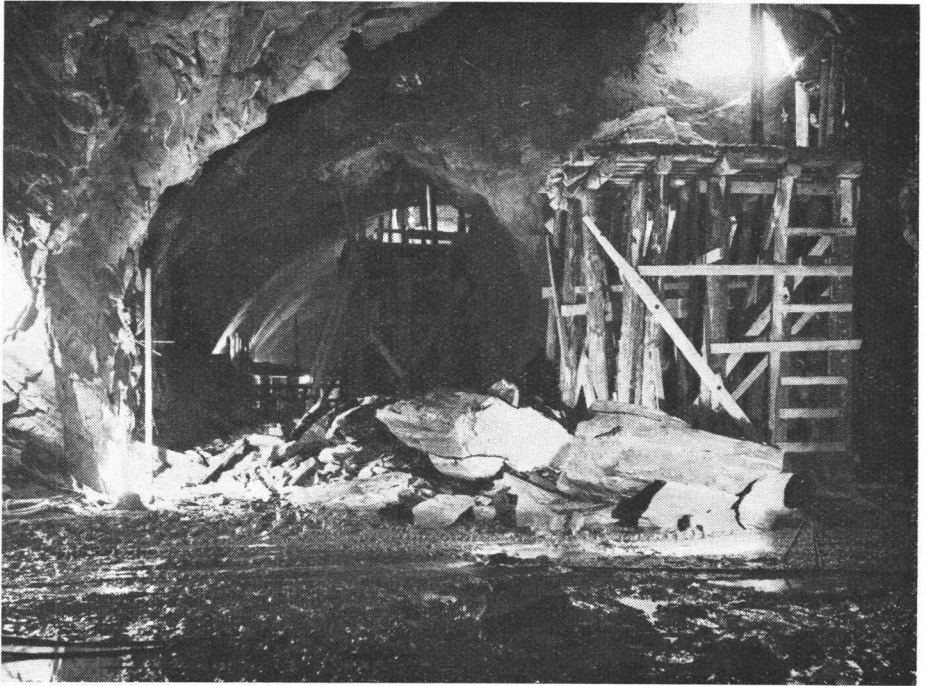
Fig. 42. Røssåga Kraftanlegg. Hvelvet med ferdigstøpt betongseksjon i maskinsalens vestre ende. Det dårlige fjellet har nødvendiggjort en omfattende stemming og bolting (18. juni 1953).
