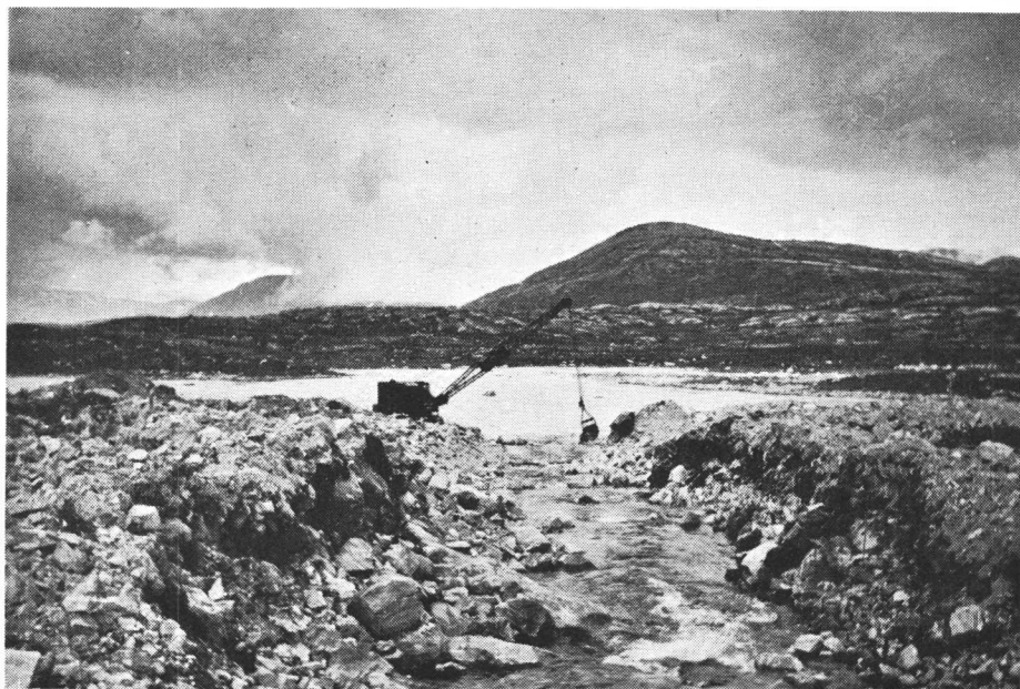
Fig. 20. Fotografi av Langvasskanalen sommeren 1950.
