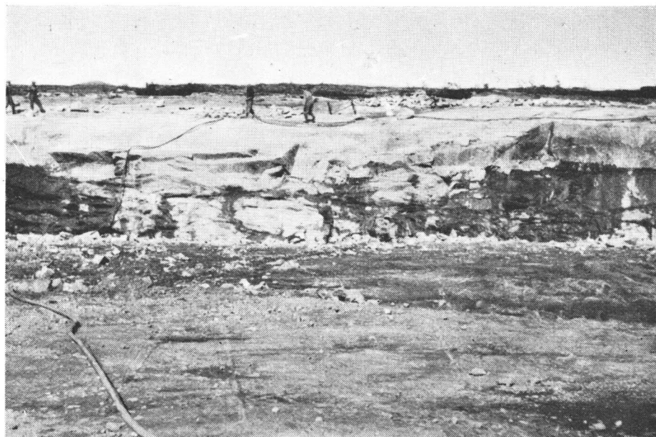
Fig. 19. Aursjødammen. Nytt steinbrudd åpnet våren 1952.
