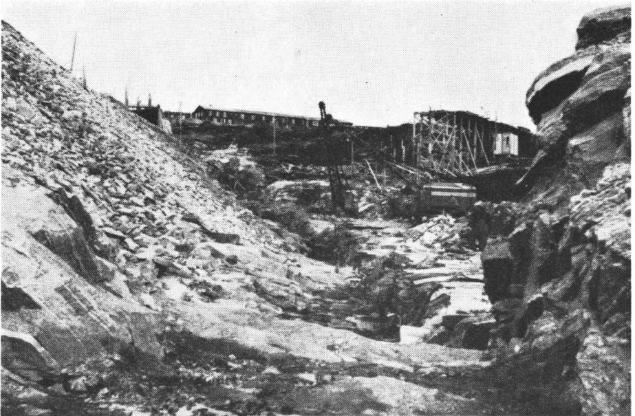
Fig. 18. Aursjødammen. Tetningsgrøft på vannsiden.
