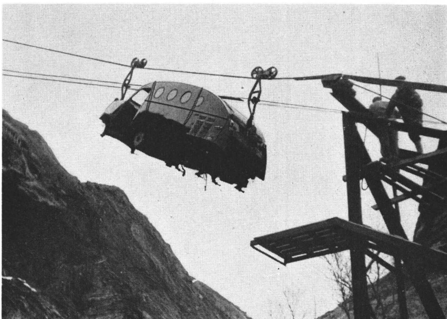
Glomfjord kraftverk. Tungtransport med taubanen.
