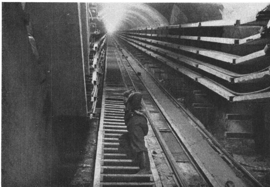
Røssåga kraftanlegg. Kabelsjakt sett nedenfra. Stigning 45°.
