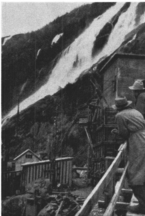
Øksenelvane. Inngang til kraftstasjonen og uttakshus.
