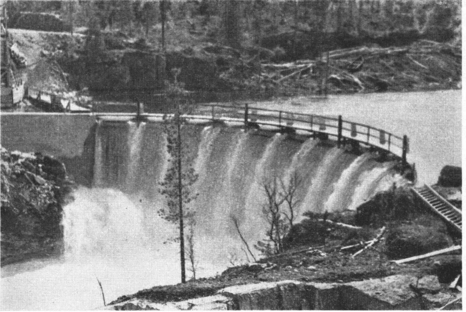
Røssåga kraftanlegg. Permanent fangdam. Flom i elva.
