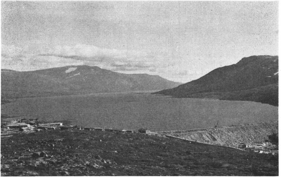
Aura kraftanlegg. Parti fra Aursjøen. I forgrunnen Aursjødammen.
