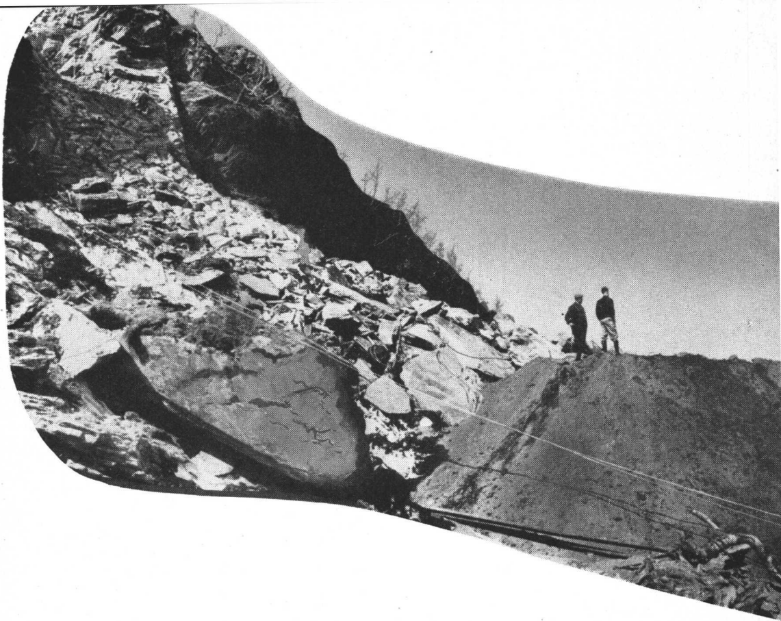
Røssåga kraftanlegg. Røssvassdammen. Fangdam med jordtetning. I bakgrunnen dypløpsseksjon.
