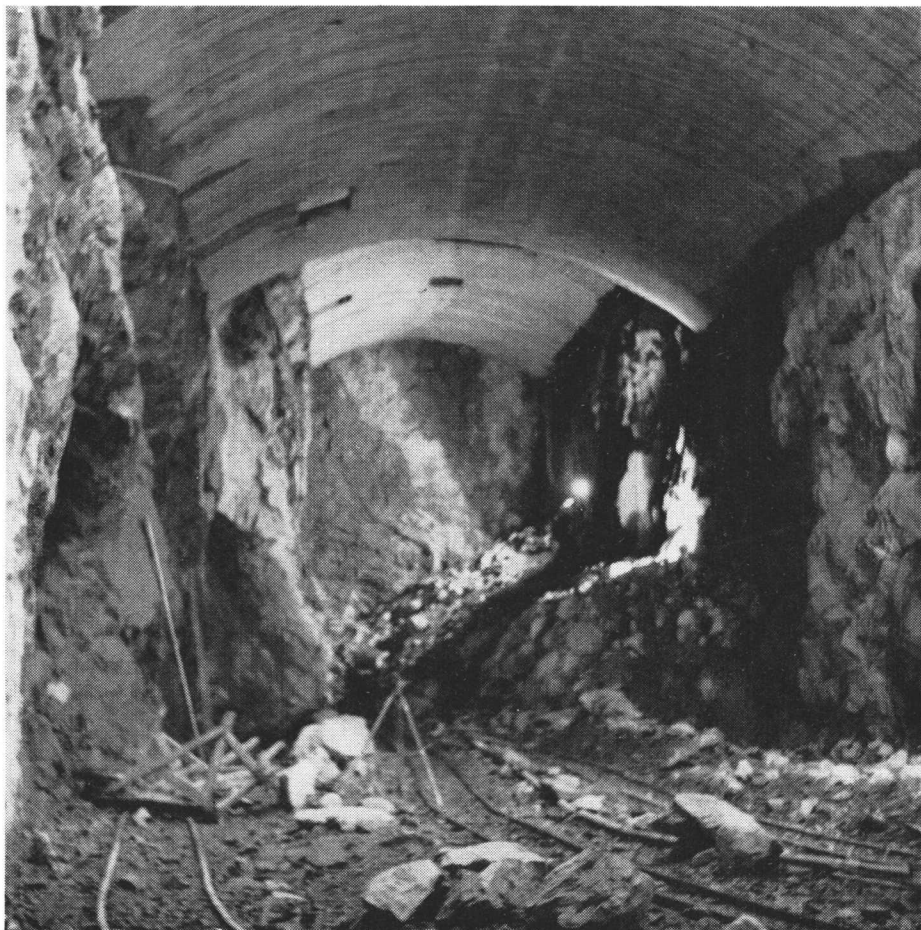
Øksenelvane. Fra utsprengning av kraftstasjonshallen.
