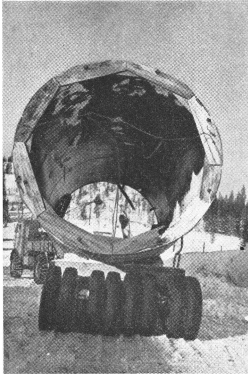
Røssåga kraftanlegg. Transport av turbinrør.
