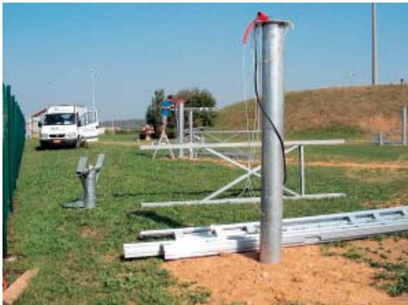
Gemeinschaftsanlage mit 9 drehbaren Anlagen von 18,36 kWp (im Bau)
