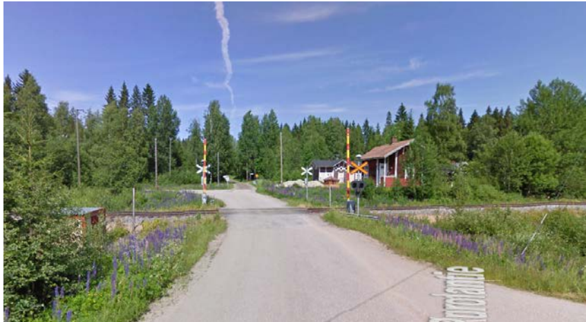
Rautatietasoristeys Kuohun taajaman pohjoispuolella
