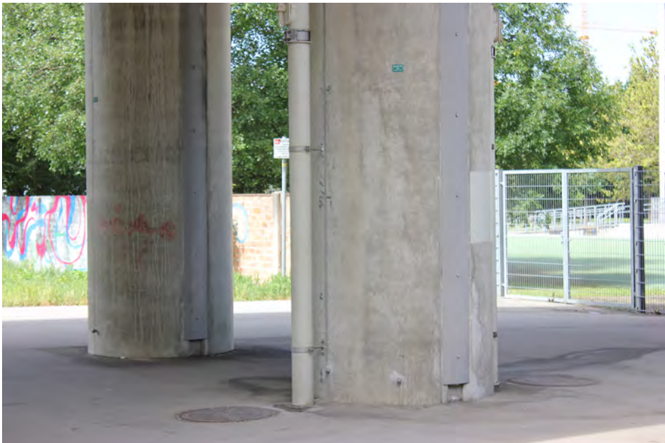
Bild 4.5 Geteilte Rundstütze eines integralen Mehrfeldrahmens
