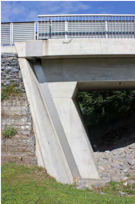
Bild 4.3 Ausführung eines flexiblen Widerlagers mit Weicheinlage
