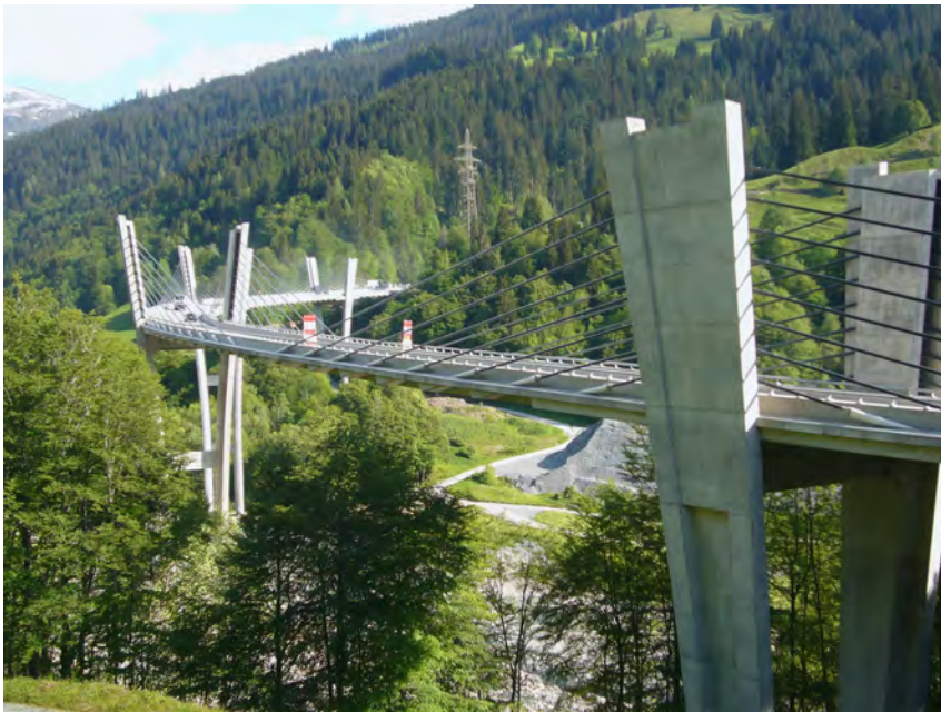
Bild 4.7 Sunnibergbrücke im Kanton Graubünden
