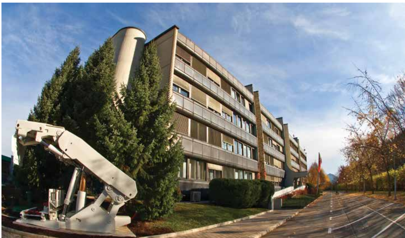
Upravna stavba Premogovnika Velenje; foto: Miran Beškovič
