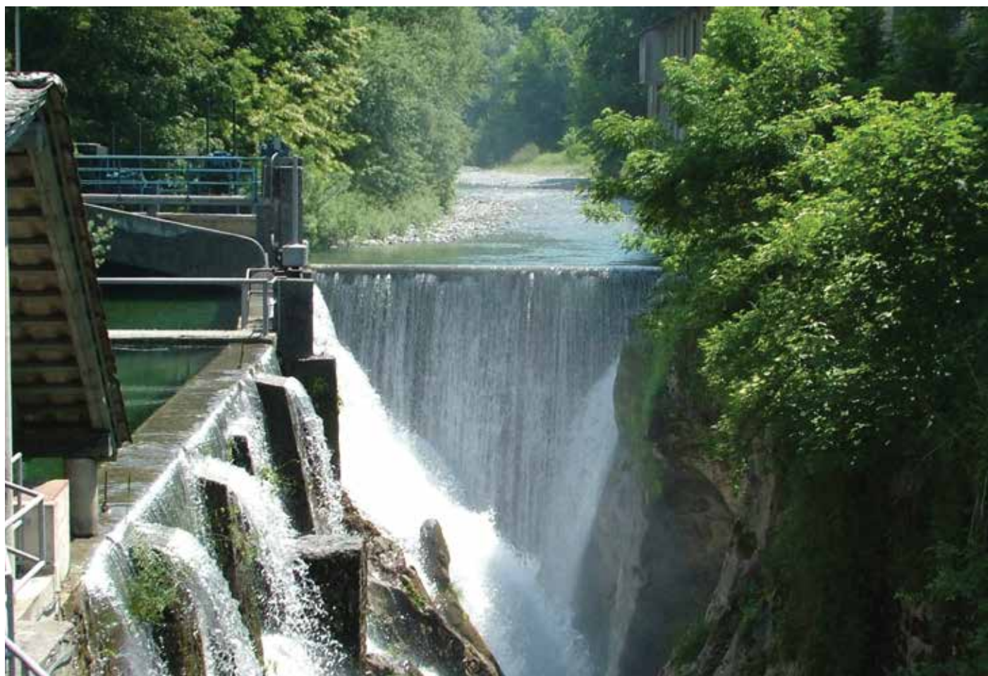
Pregrada mHE Podmelec; foto: Arhiv SENG
