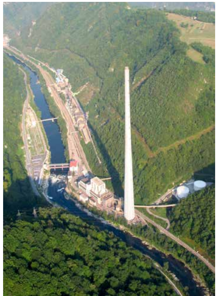
Lokacija Termoelektrarne Trbovlje; foto: Arhiv TET
