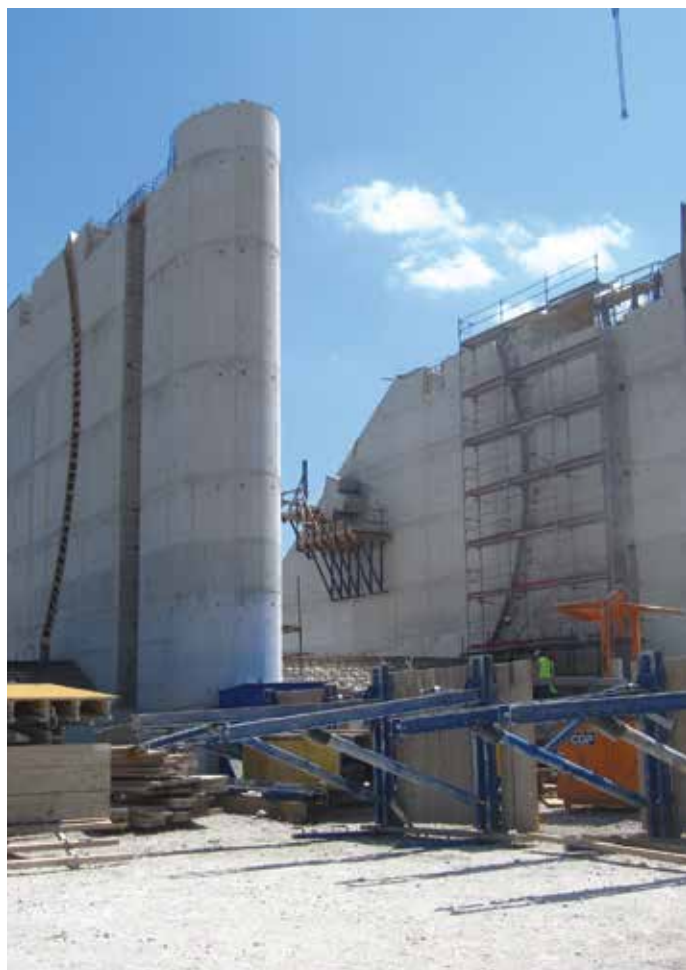
Gradbišče HE Brežice; foto: Arhiv HESS
