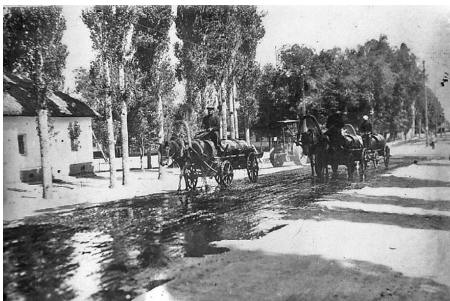
Асфальтирование городской улицы
