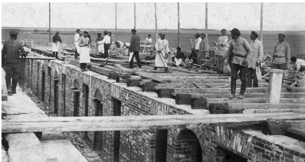
«Интергельпо» на строительстве хирургической больницы.
