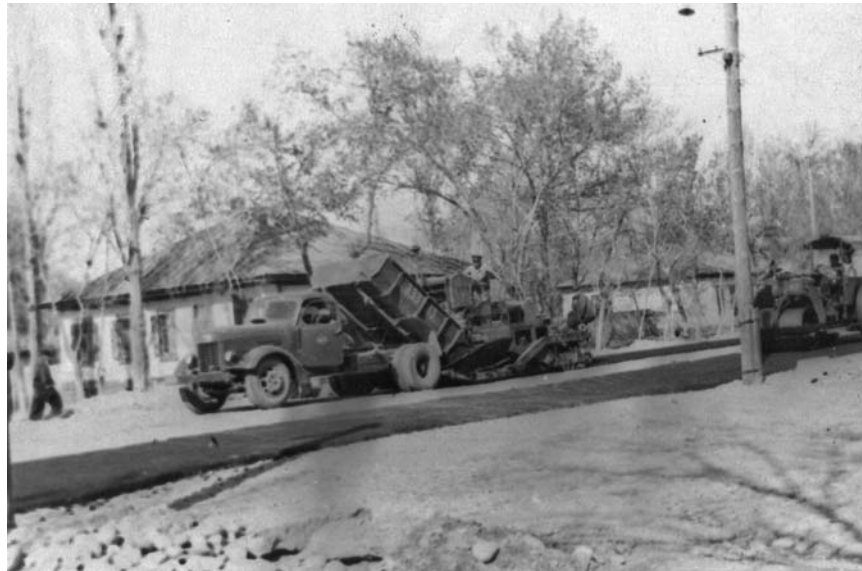
Асфальтирование улицы Фрунзе.
