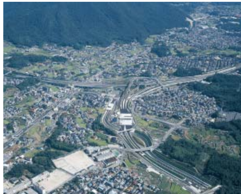
[1] 高速1号線から山陽道への分岐部
