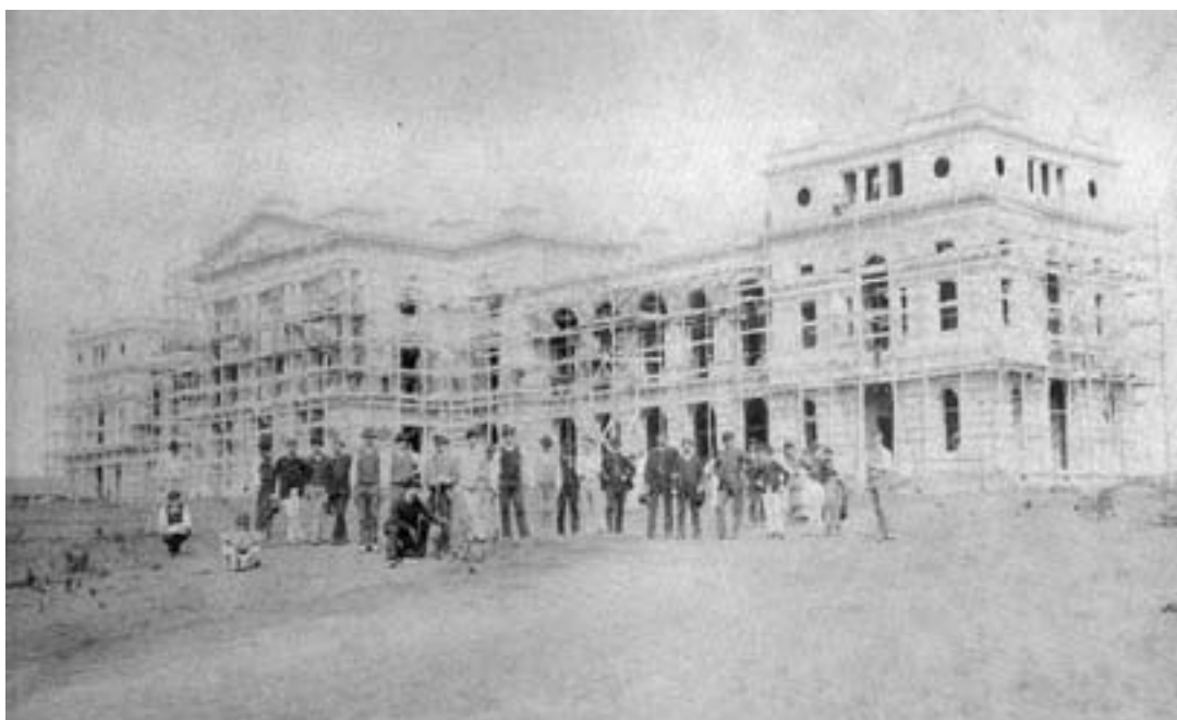
O Monumento do Ipiranga em construção, em 1888.
