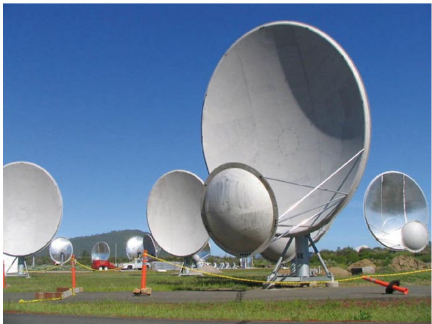
► Abb. 4: Das Allen Telescope Array (ATA), das zur Zeit am Hat Creek Observatorium (Kalifornien) gebaut wird, besteht aus 6-m-Parabolanntenen mit seitlich versetztem Fokus. (Quelle: SETI Institute)
