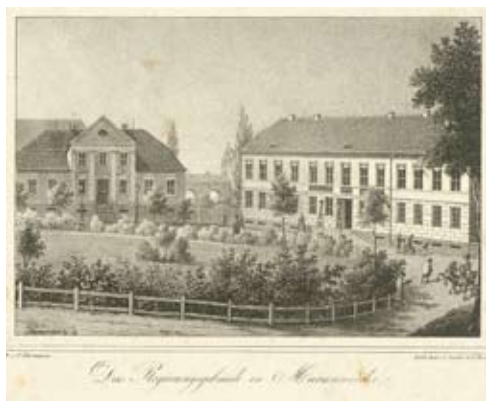
Im Regierungsgebäude (rechts) residierte die bis 1808 Kriegs- und Domänenkammer genannte Verwaltung der Provinz Westpreußen
