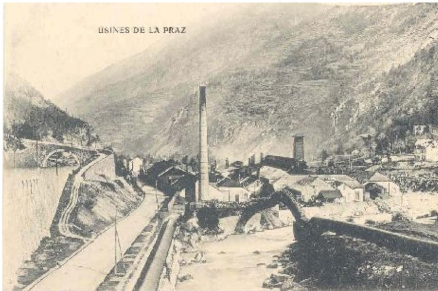
Usine d'aluminium de La Praz. La conduite forcée franchi l'Arc suivant une technique imaginée par Paul Héroult. C'est la première conduite autoportante du monde, construite en 1893.
