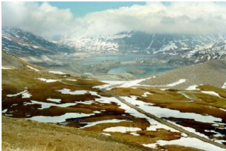
Le barrage du Mont-Cenis vidé. On distingue la digue en enrochement et l'ancienne digue italienne.
