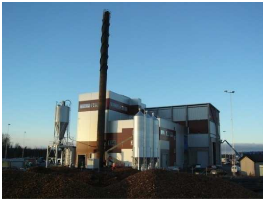
Fjärrvärmeanläggningen, foto Dick Ljungberg
