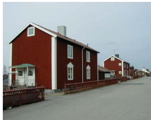
Arbetarbostäder uppförda år 1918 för Tidaholms Bruk, arkitekt Gunnar Asplund 17 .
