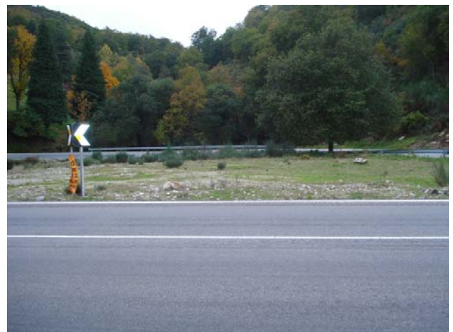
Parte superior da escombreira de montante. Zona já utilizada para deposição de escombros na construção de Venda Nova II, onde foi regularizada uma curva da estrada existente
