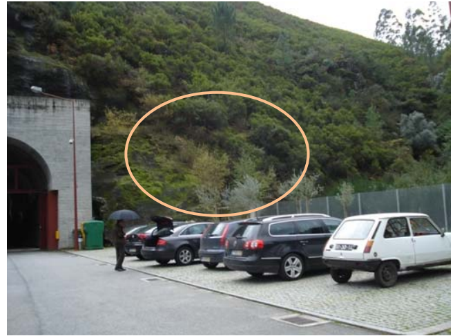
Local de abertura do novo túnel
