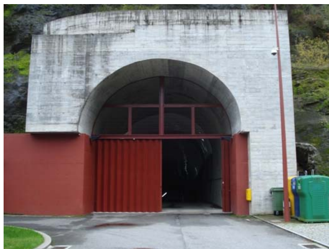
Entrada do túnel da central de Frades
