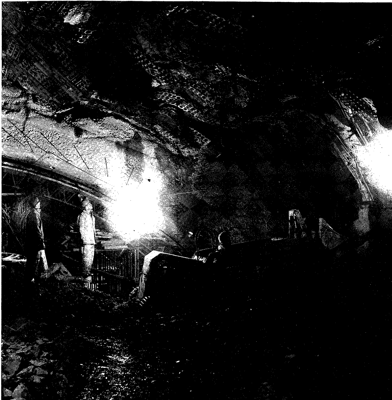
Excavation de la centrale souterraine de Curbans en cours de construction.
