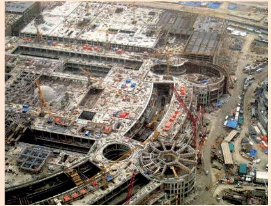
Торговый пассаж, Дубай, ОАЭ, 300 000 м 2 . Самый большой в мире шопинг-молл с системой пост-напряжения
