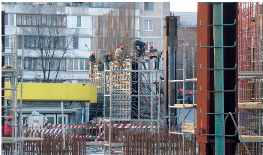
Строительная площадка многофункционального комплекса Sky Towers по проспекту Победы в Киеве, сделка по продаже которого была закрыта в 2012 году
