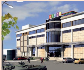
Торгово-офисный центр DEPO't Center, Донецк, Украина (на стадии строительства)
