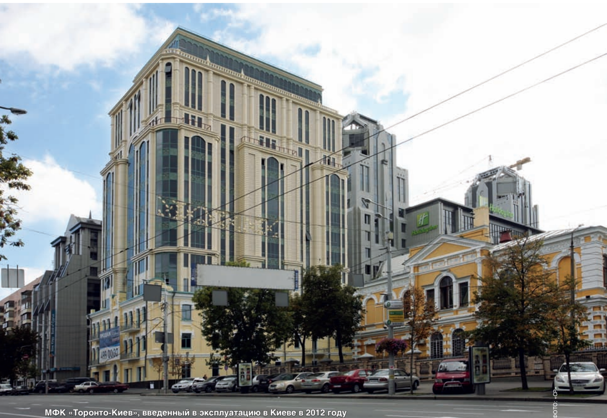
МФК «Торонто-Киев», введенный в эксплуатацию в Киеве в 2012 году
