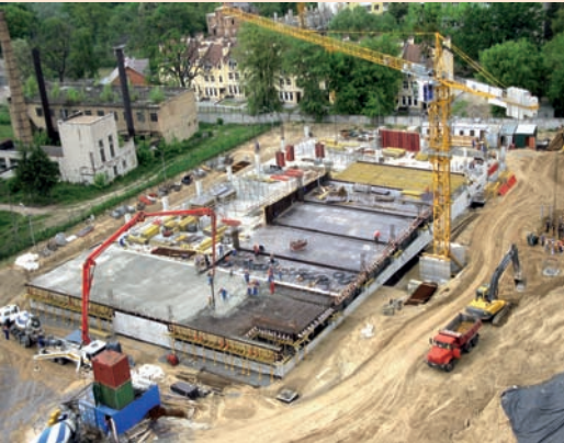
Новый комплекс Посольства США в Киеве, Украина. Монолитное железобетонное здание гаража с системой пост-напряжения
