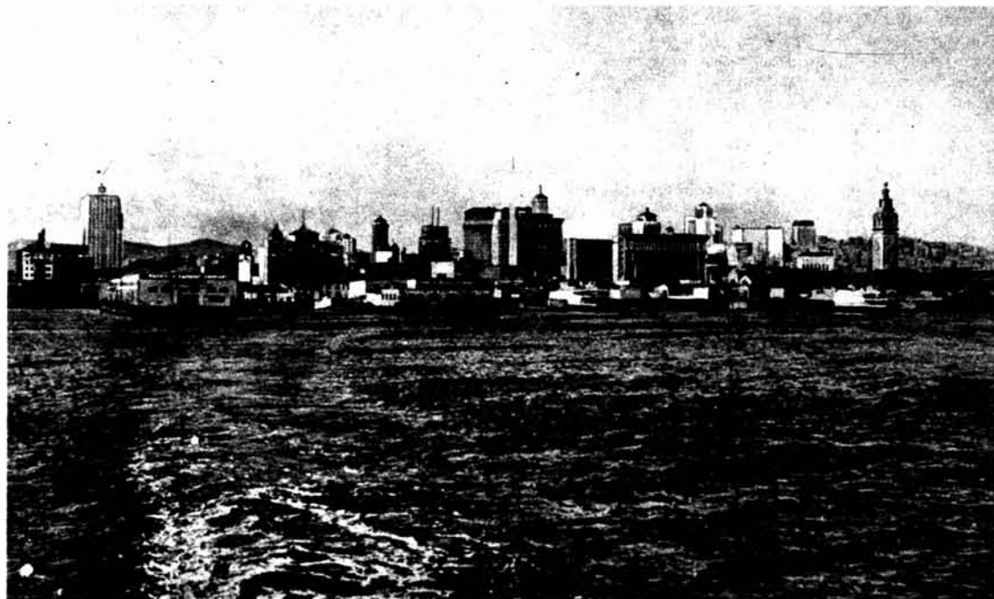
Hoe San Francisco na de aardbeving van 1906 werd opgebouwd.
