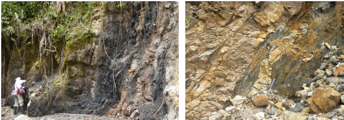
Figura 55. Afloramientos de capas medias a gruesas de areniscas cuarzosas con intercalaciones de lodolitas negras muy fracturadas. Camino a cabecera de la Quebrada Caney (cuadrícula G-12).
