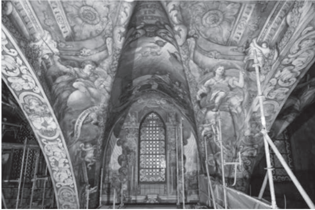
Zona de luneto y bóvedas de cruceña de la Iglesia de San Nicolás de Valencia, tras la restauración.
