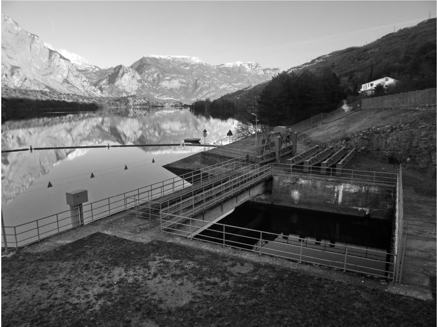
Opera di presa al lago di Cavedine
