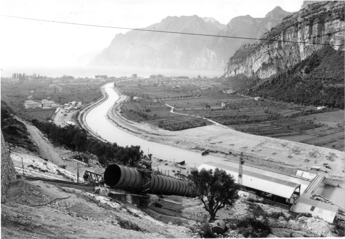
Panoramica sullo stato di avanzamento dei lavori
