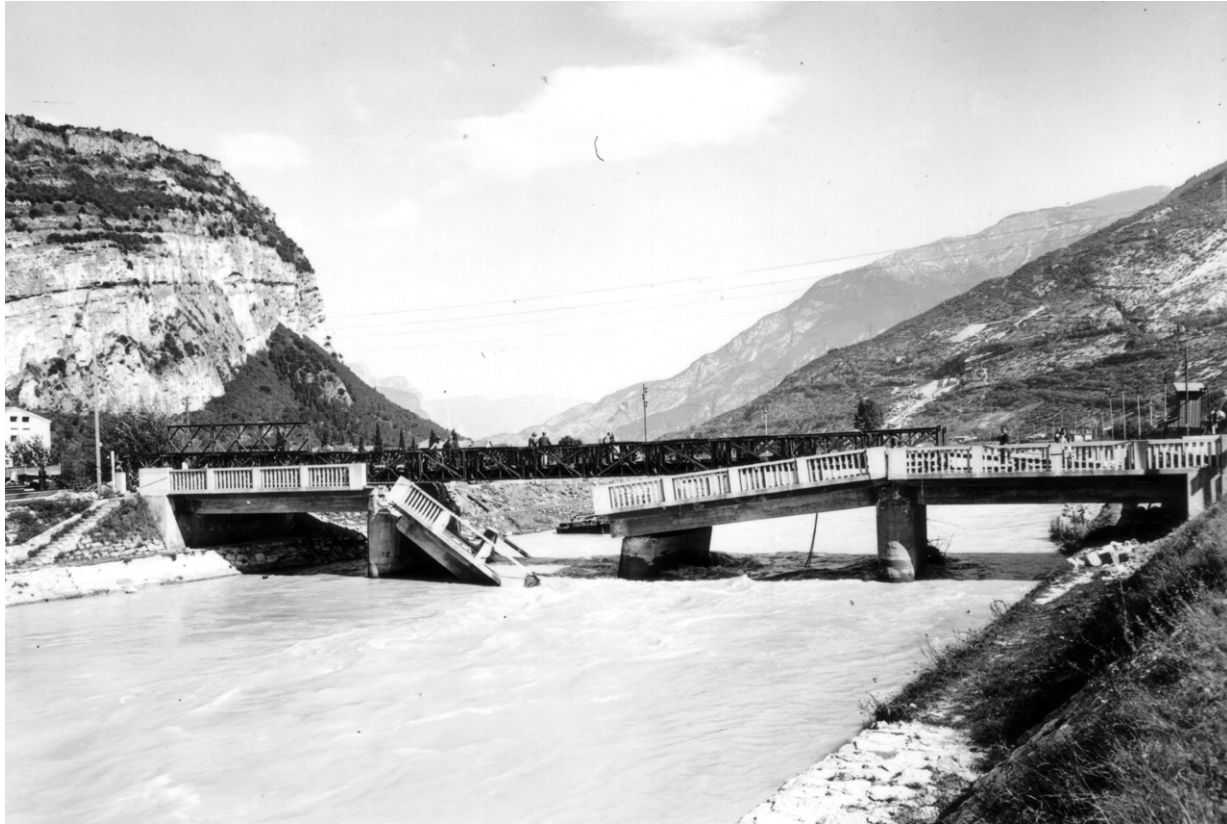
Il ponte danneggiato con ancora visibile lo zatterone
