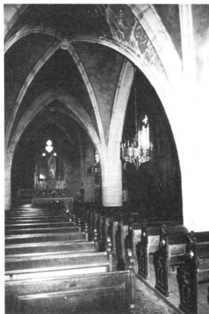
Vue intérieure de l'église : collatéral nord
