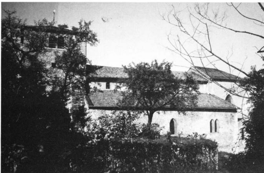
Vue d'ensemble : face sud
