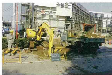
建設中の群馬学習センター
