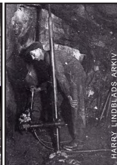
Skottvångsgruva, år 1918. Israelsson, Lövråten, borrar med en tryckluftsborr.
