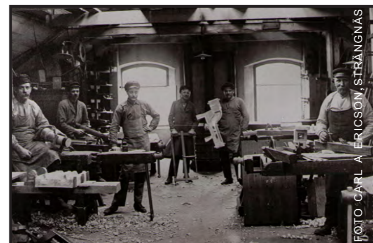
Modellsnickeriet, 1922. Här tillverkades modeller till gjuteriet. I gjuteriet gjordes sedan formar som järnföremålen göts i. Fr v Anton Eriksson, Gustav Larsson, Nils Svensson, Edvin Södersten, Ragnar Insulander och Isak Håkansson.
