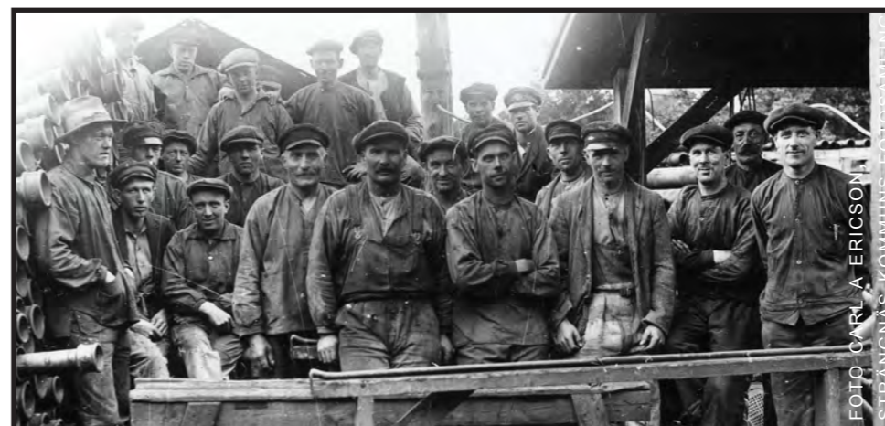
Arbetare vid Åkers Styckebruks rörgård, 1927.
