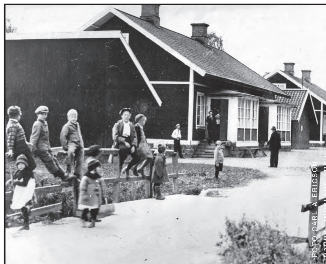
Bruksarbetarbarn i Täbylund. Den första byggnaden med sitt uthus finns kvar i stort sett oförändrad.
