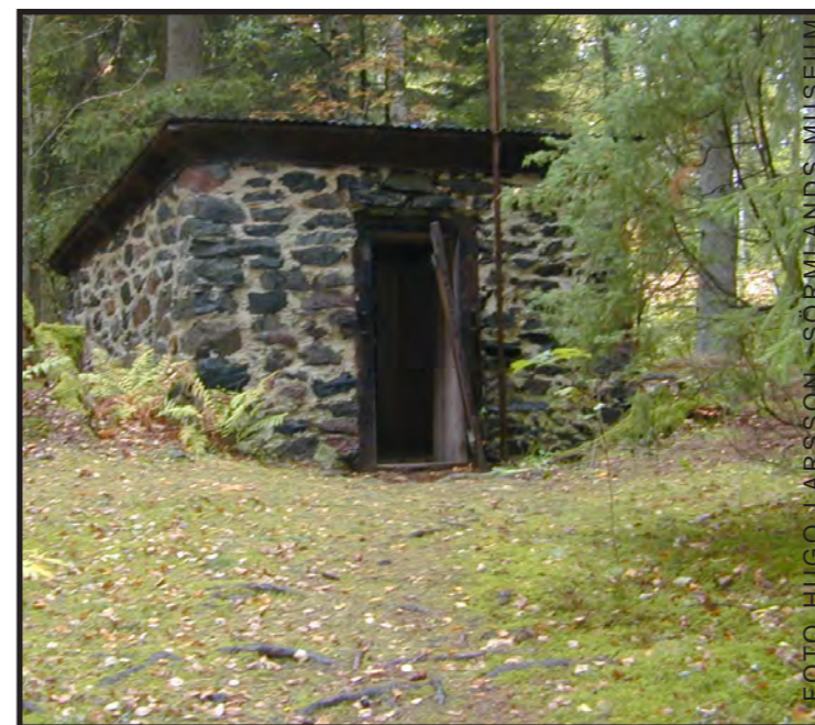
Sprängmedelsförrådet, troligtvis byggt under 1800-talet. På grund av det farliga sprängmedlet som förvarades här ligger huset en bit ifrån övriga bebyggelsen.
