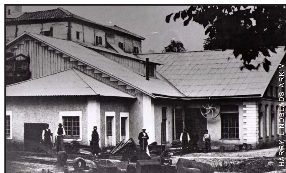
I anslutning till masugnen byggdes gjuteriet, som stod färdigt 1873. Gjuteriet ritades av ingenjör C Laurenius. Byggnaden revs på 1980-talet. Bilden är tagen omkring 1885.
