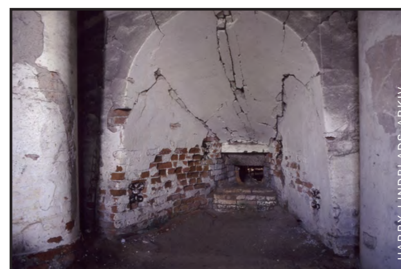
Inne i Björndammens masugn. Här tappades det flytande järnet ur masugnen.
