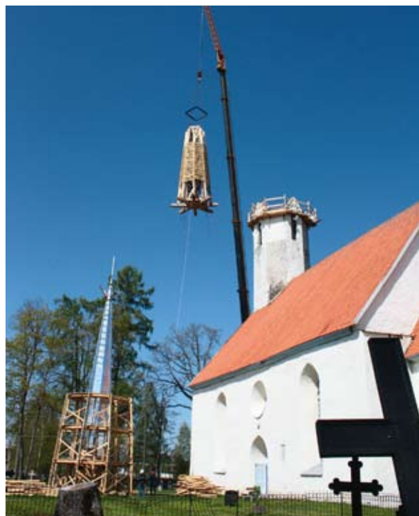
(1) Väike-Maarja kiriku tornikiiver pärast avariid. Ankurdamise puudumise tagajärg. Foto Ain Pihl
