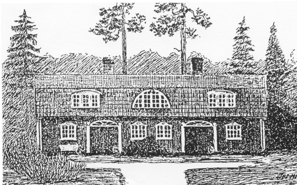
Stallbyggnad flå Mörtfjlk.
