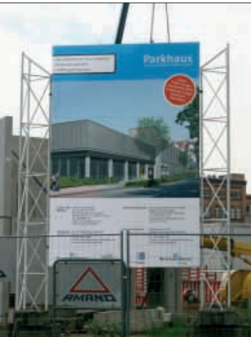
Baustelle an der Nordzufahrt
