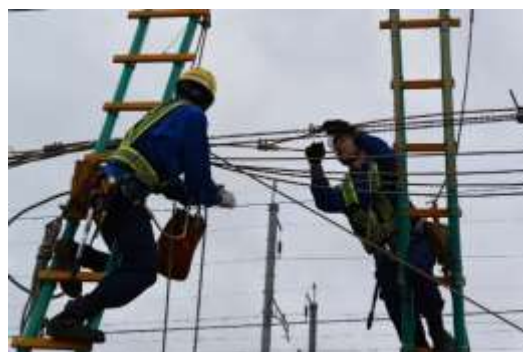
【電気係員による架線張替訓練】
