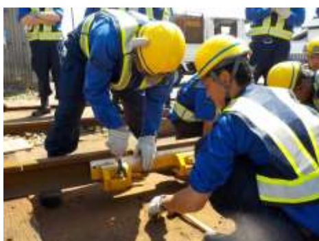
【施設係員によるレール折損対応措置訓練】
