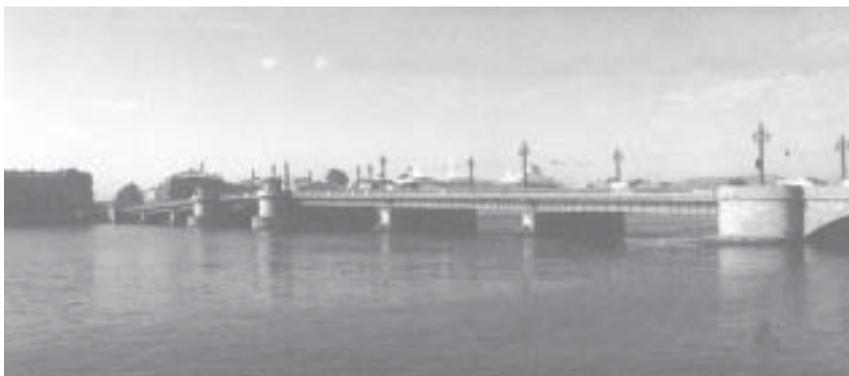
Разводной пролет из двух стальных консолей и единая неразрезная балка, перекрывающая три пролета с каждой стороны от разводной части. Фото 2004 г.
