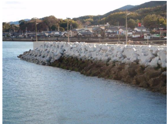
黒磯港消波ブロック
