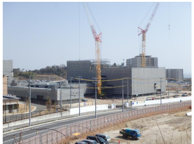
防災センター工事
